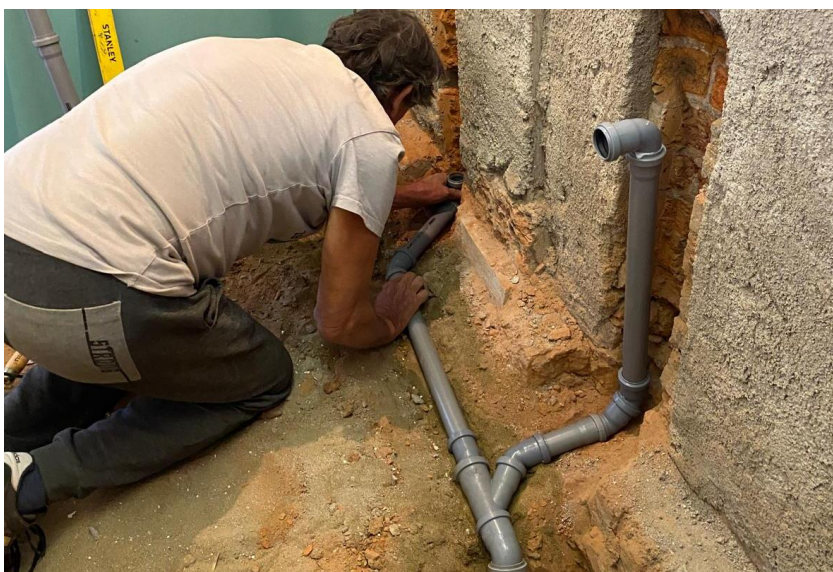
Leiding leggen, graven, stuken, tegelen enzovoort! Een eenvoudige badkamer werd gebouwd. En er werd prima werk geleverd.
