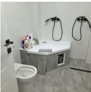
In de badkamer moest een verhoging worden aangebracht zodat Edy vanuit zijn rolstoel makkelijk kan overstappen
