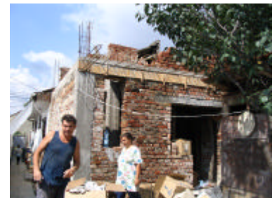
De aanbouw op de voorgrond, nu het dak nog
