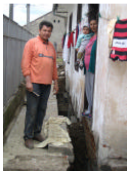
Het fundament werd eerst versterkt
